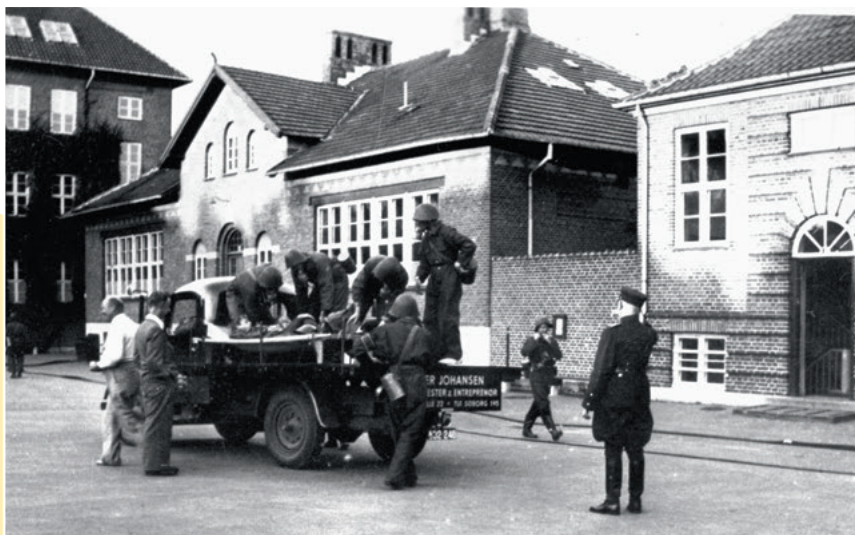
Civil Beskyttelses Vagten holder øvelse i Søborg Skoles gård i 1941. I forgrunden til højre instruktøren fra Falcks Redningskorps. Det ses, at de CB-værnepligtige er fuldt feltmæssigt udrustet med stålhelme og gasmasker, og at det er den lokale brandinspektør, tømremester og entreprenør Peter Johansen fra Runebergs Alle 22, der har lagt lastbil til.
