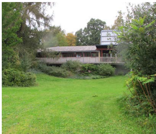
Den eksisterende bebyggelse Ringbo.
