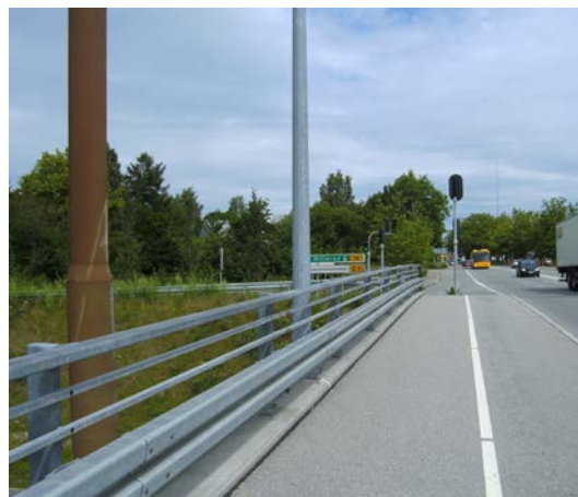
Foto taget fra motorvejsbroen og ind mod Ringbo.
